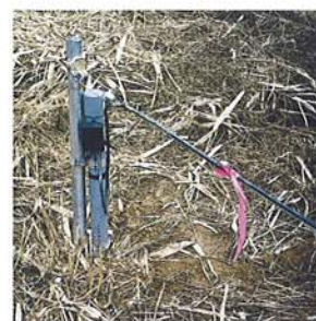
地表傾斜センサーとしての施工例
